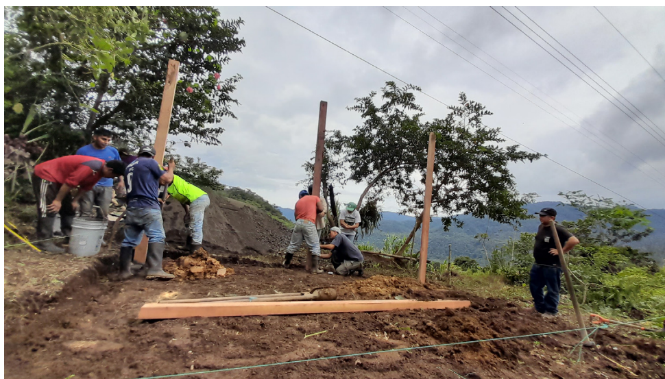
Figura 2. Construcción de biofábrica, para producción de biol y manejo de desechos. Construction of a biofactory for biol production and waste management.
