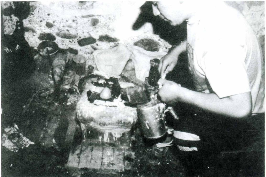
Figura 12. El crisol está cocido en la llama del soplete.
