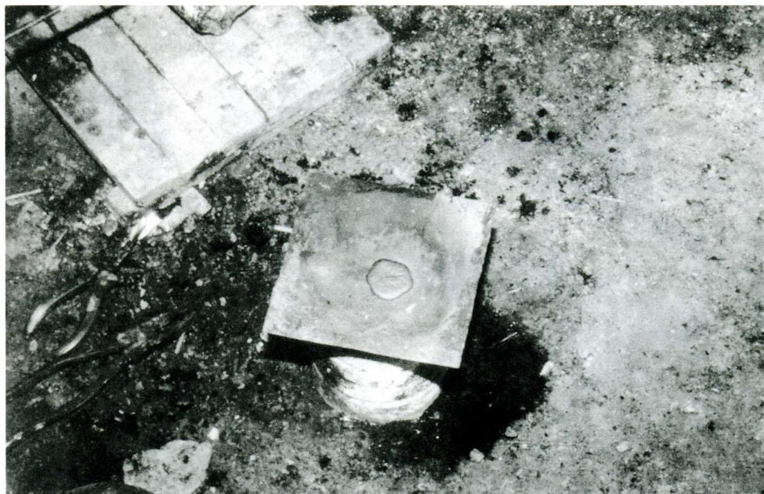
Figura 16. La plata enfriada en la chapa.
