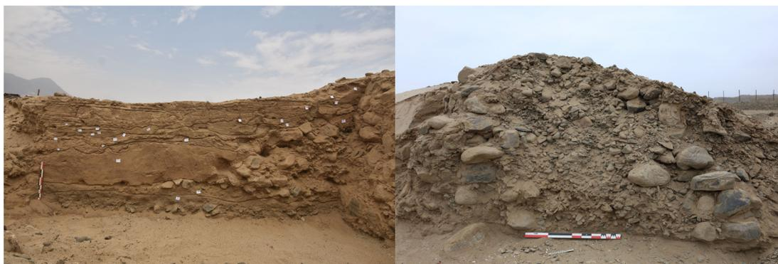
Figura 9. Vista en perfil de un segmento de la Muralla Chimú, ubicada al norte de Chan Chan. Véase la gran cantidad de sedimentos acumulados sobre la cara este de la muralla. Véase también la forma de talud inclinado de la cara oeste para dar más resistencia a la muralla ante los impactos inminentes de aluviones y descargas fuertes de agua.
