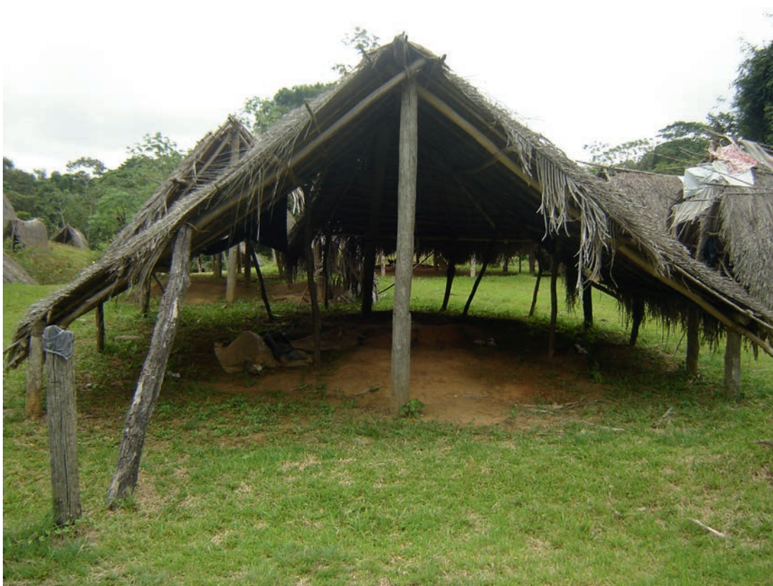
Figura 18. Construcción en madera del cementerio de Cartí en Guna Yala (foto: Ainslie Harrison). Timber building in the cemetery of Cartí in Guna Yala (photo: Ainslie Harrison).
