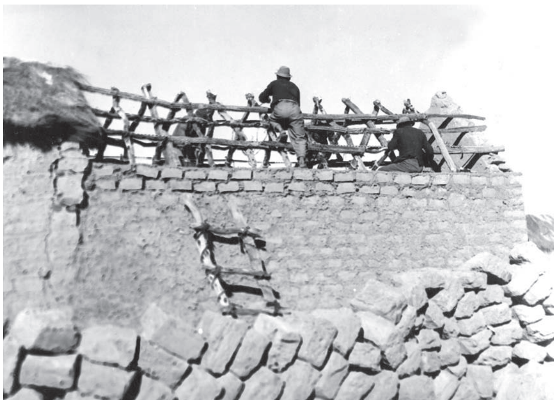
Figura 21. Construcción de las armaduras.
