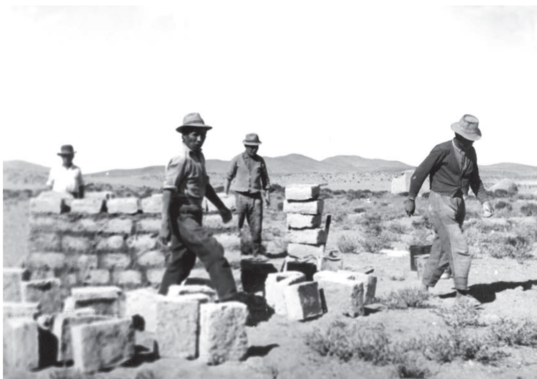
Figura 16. Construcción de adobes.
