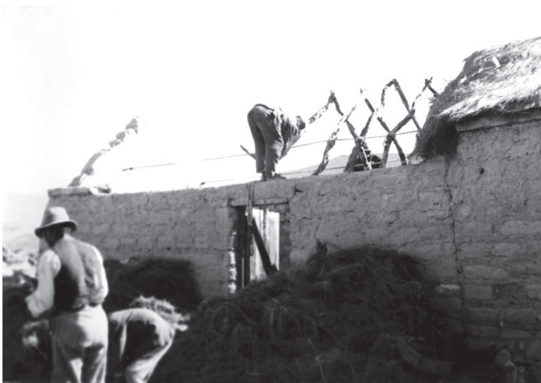
Figura 20. Construcción del techo.
