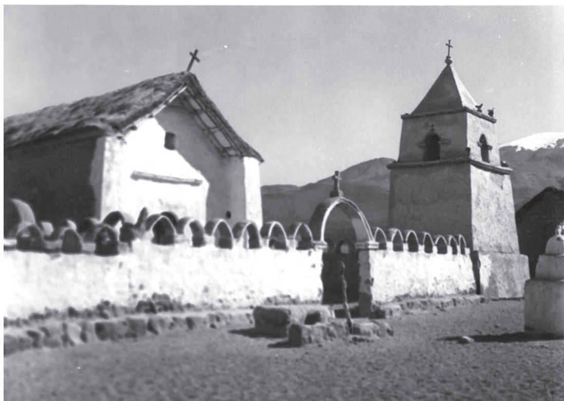
Figura 3. Iglesia de San Santiago, Santo Patrono de Enquelga, construida de adobes y piedras.
