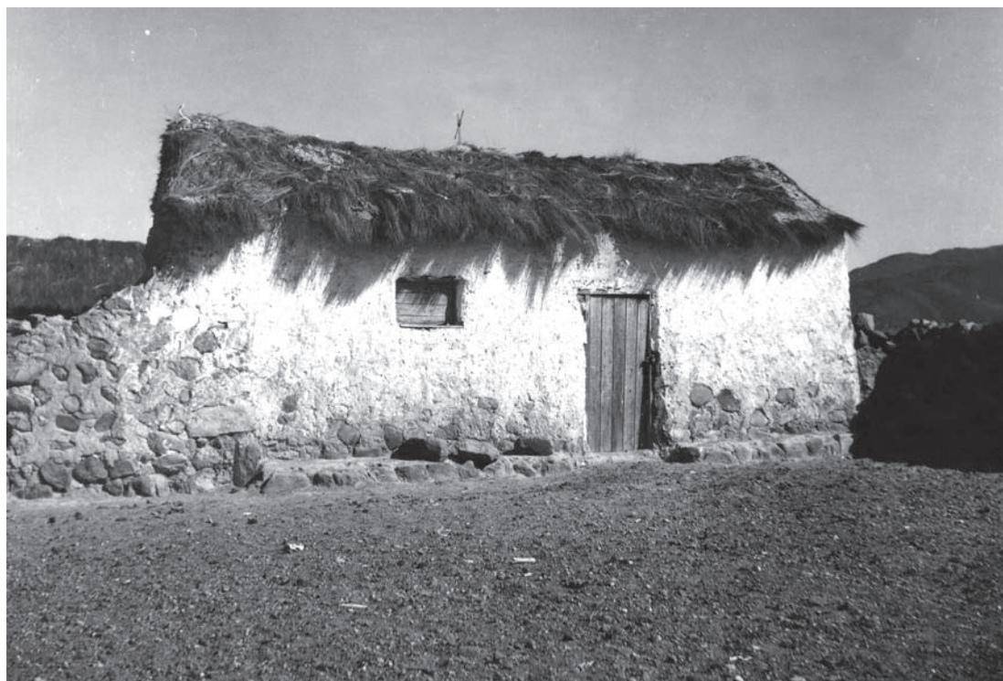
Figura 8. Casa de adobes con piedras (N o 36).
