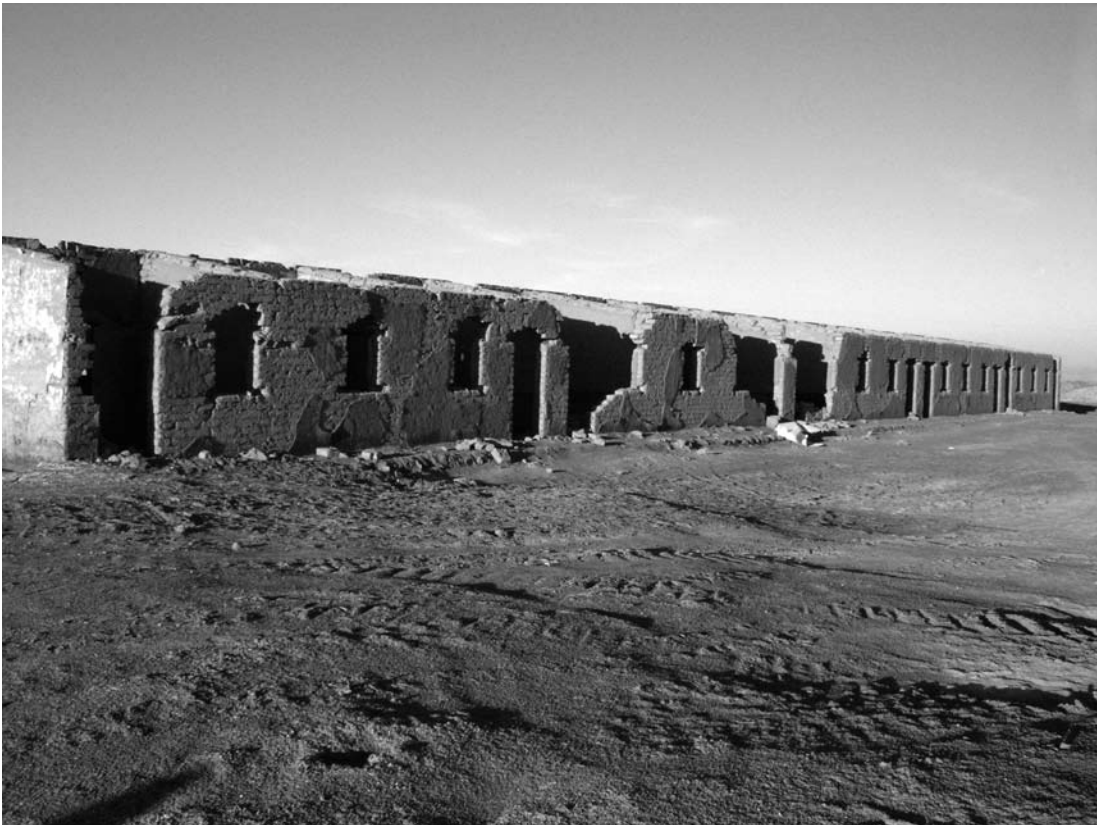
Figura 3. Vista actual de un sector habitacional de la oficina José Santos Ossa (Fotografía de Flora Vilches). Current view of a living quarter in Oficina José Santos Ossa (photograph by Flora Vilches).
