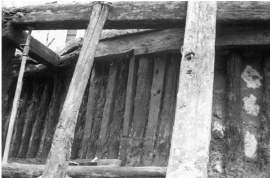
Figura 5. Detalle de piezas de embarcación utilizadas en la construcción del muelle, parte 2.
